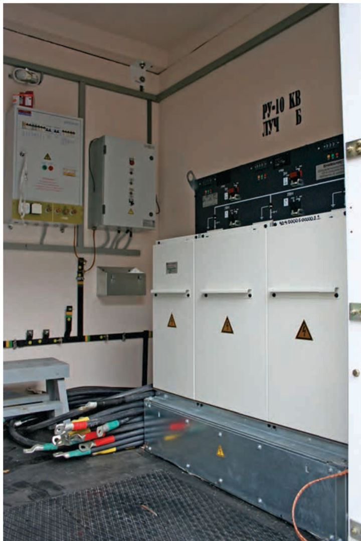
Устройство высокого напряжения
