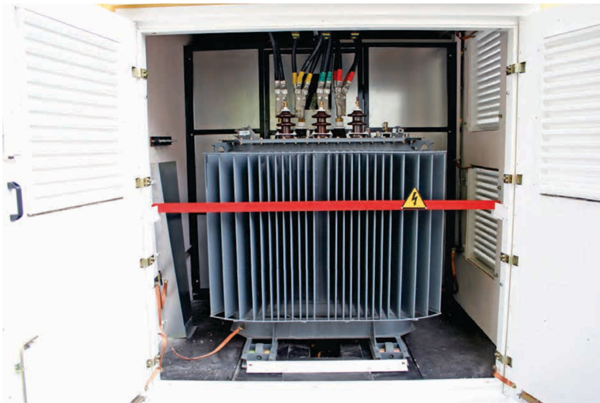
Отсек силового трансформатора
