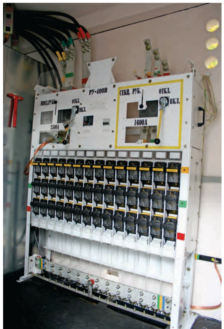
Устройство низкого напряжения
