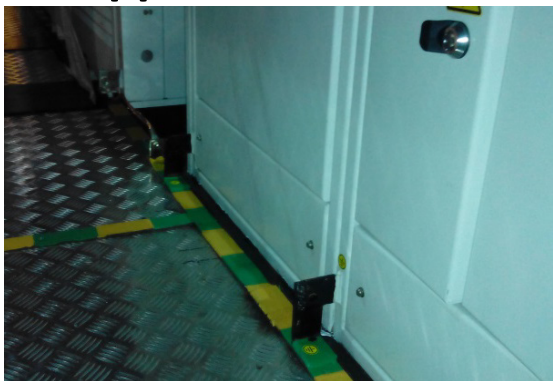
Система заземления согласно требованиям ПУЭ
