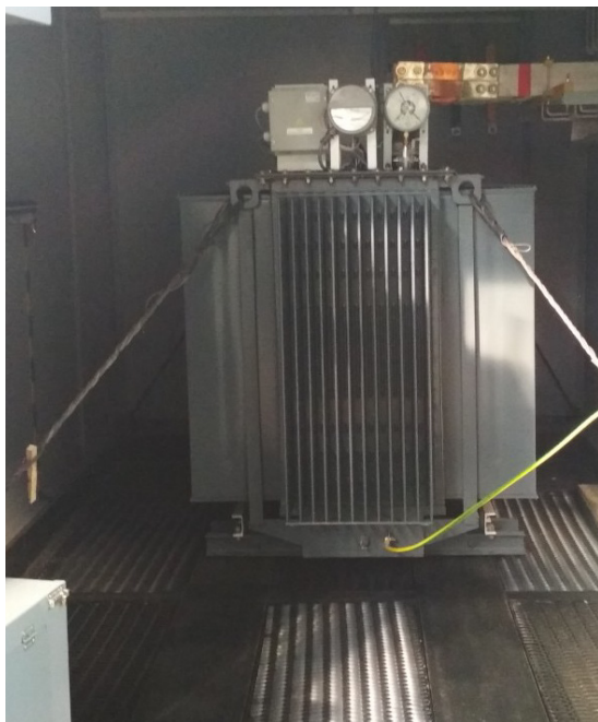
Трансформатор ТМГ до 2500 кВА Маслоприемник на 100% масла
